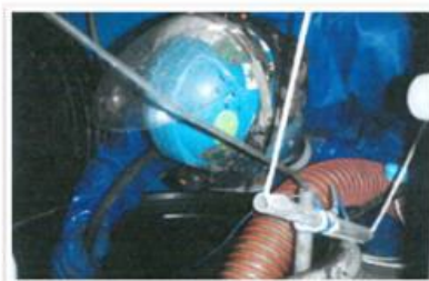
特殊清掃・化学プラントメンテナンス
